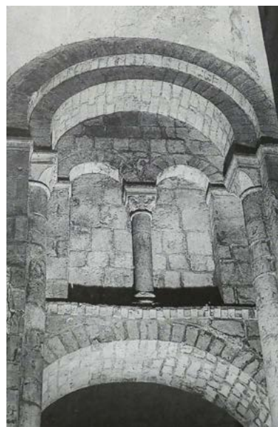
Fig. 6 : Arcades dans la travée sous le clocher nord (photo J. Cabanot).
