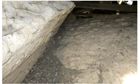
Fig.2bis : Départ du berceau de la nef (photo R. Jarris).
