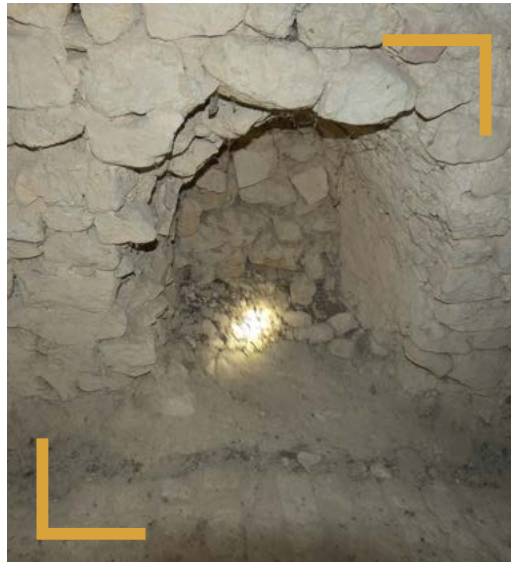
Fig. 2 : Ancienne baie aujourd'hui murée (photo R. Jarris)
